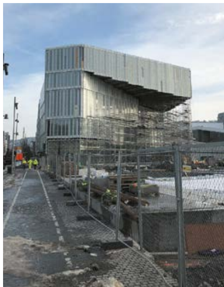
Nedteilingen har begynt. Byggeplass i dag. Oslos hovedbibliotek om et drøyt år. (Foto: Deichmanske bibliotek)
